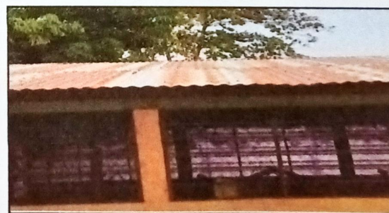
Foto 6: Foto 3: Sustrución de lámina, por lámina troquelada aluzinc calibre 26 sustitución de capote de lámina para lámina acanalada y sustitución de elementos de fijación
