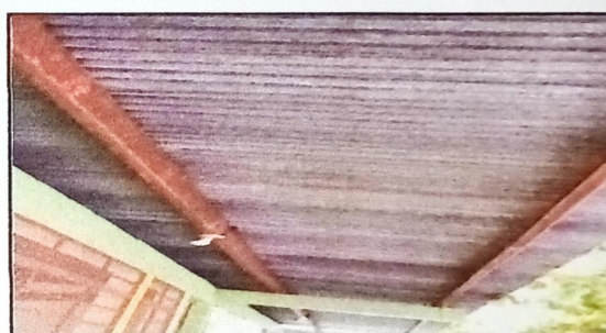
Foto 4: Foto 3: Sustrución de lámina, por lámina troquelada aluzinc calibre 26 sustitución de capote de lámina para lámina acanalada y sustitución de elementos de fijación
