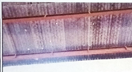
Foto 3: Sustrución de lámina, por lámina troquelada aluzinc calibre 26 sustitución de capote de lámina para lámina acanalada y sustitución de elementos de fijación
