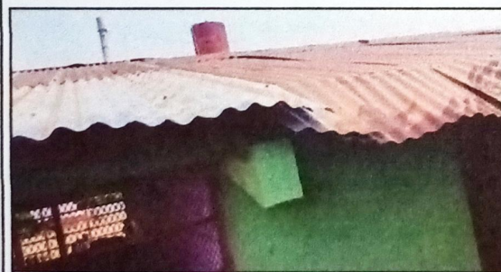
Foto 5: Sustrución de lámina, por lámina troquelada aluzinc calibre 26 sustitución de capote de lámina para lámina acanalada y sustitución de elementos de fijación
